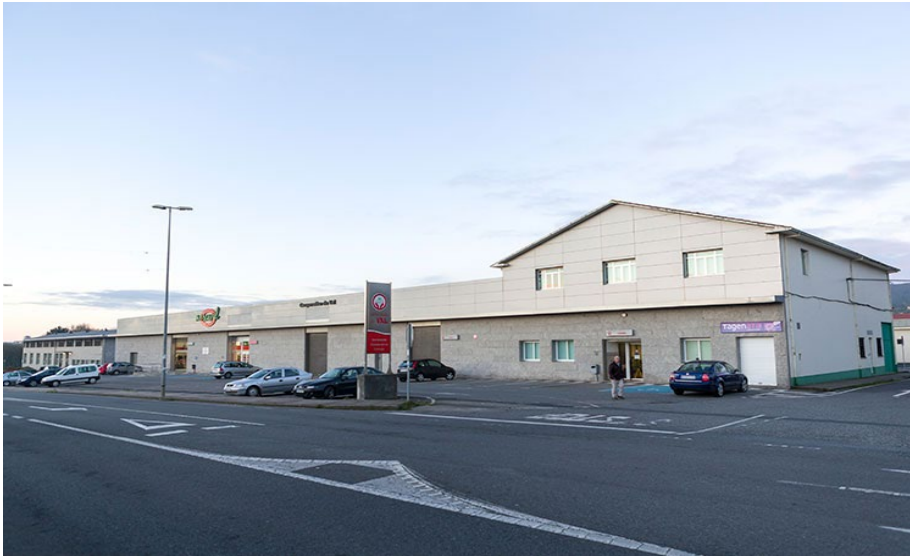
Instalacións da cooperativa do Val en Estrada de Valdoviño, 459, 461, 15541 Narón, A Coruña
